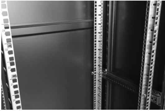
- zamontować koszyki pod śruby M6
